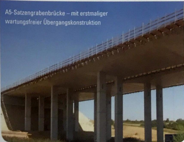
UHPC ermöglicht z.B. mit Systembrücken Ressourceneffizienz und formschöne Gestaltung.
